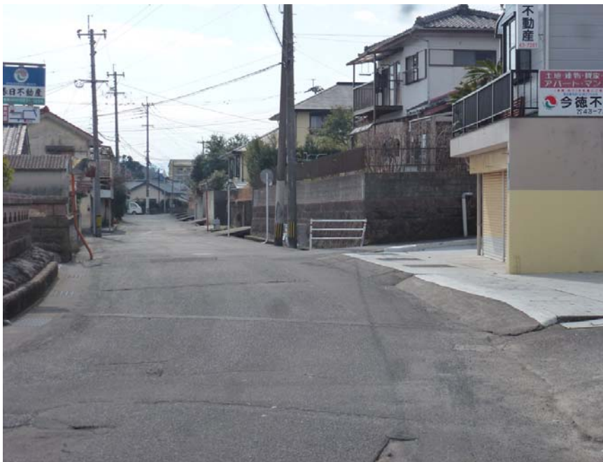
雨の日水量が多く危険であり、側溝蓋かフェンスの要望
