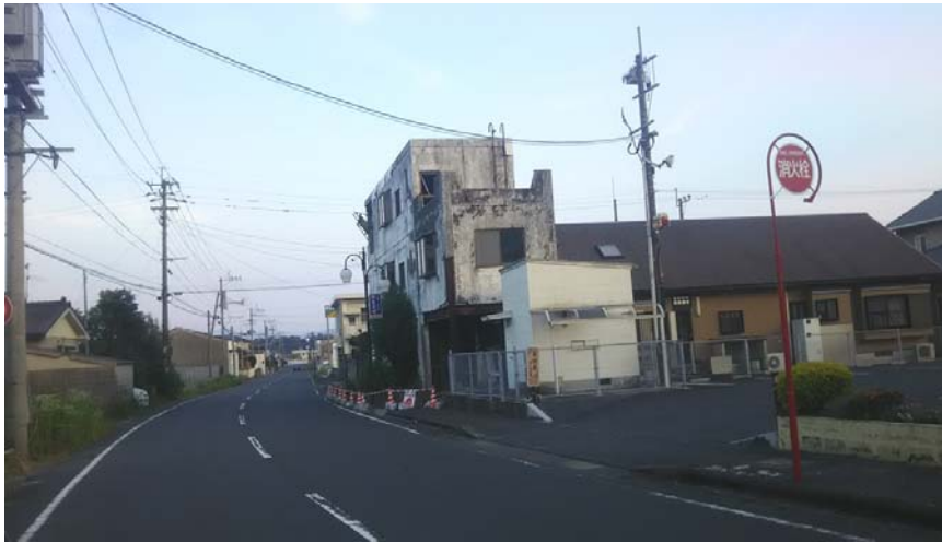
西祓川弥生会館横建物 建物危険箇所 歩道が通れず危険
